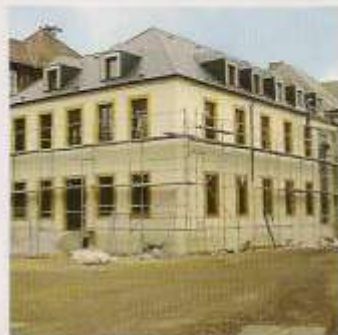
Fin du chantier
