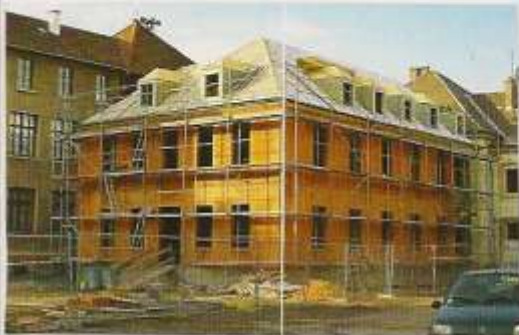
Début du chantier
