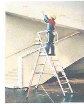
Plate-forme individuelle roulante (PIK). en rouge les stabilisateurs.
